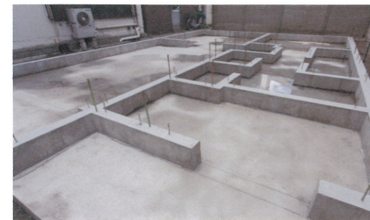
「べた」とは、全面にコンクリートを打設すること。高い部分(立ち上がり)に建物の土台が乗ります。
